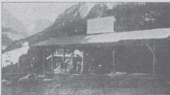
Fig. 28. Obere Bremsbergstation (Annahme auf der Poststraße).
